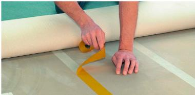
La cinta de doble cara para la fijación de moquetas y césped artificial que destaca por ser removible, por lo que es perfecta para la colocación de suelos de manera temporal. Además, una vez retirada no deja residuo y puede cortarse con la mano, lo que facilita el montaje.
