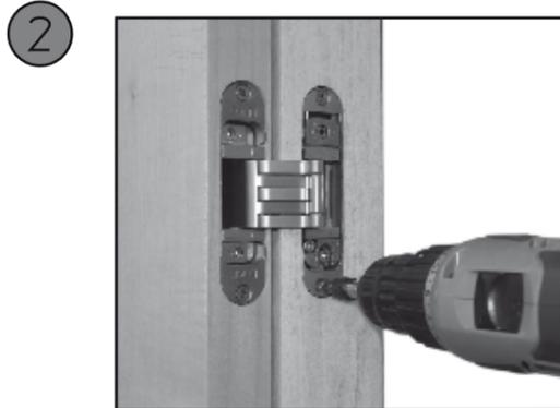
\* Instalar la puerta en el marco, alojando las bisagras en los correspondientes mecanizados. Fijar las bisagras con los tornillos.
