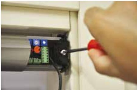
**8** Regular la longitud de la automatización y apretar el tornillo sobre el estribo lateral.
